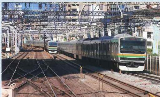
田町駅から東京方面の様子で、右の列車は東海道線下り列車です。山手線外回り（右から4本目）、京浜東北線南行（右から3本目）、東海道線上り（右から2本目）を順次移設して、東海道線上下線間に羽田空港アクセス線（仮称）のスペースを確保していきます。奥に見える信号機付近から、羽田空港アクセス線（仮称）が始まります。
